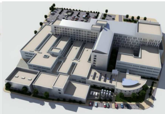
Visión trasera final de obra
