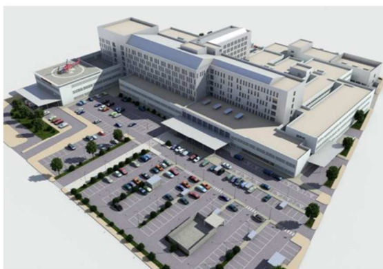
Visión delantera final de obra
